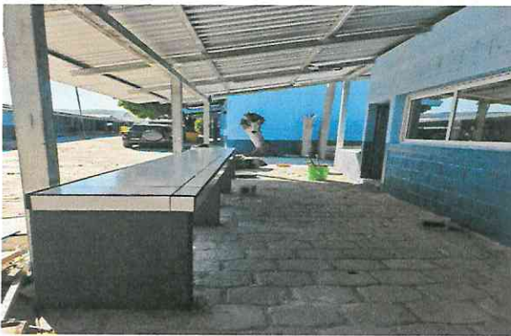
Foto 3: Reparación e instalación de servidor de alimentos.
