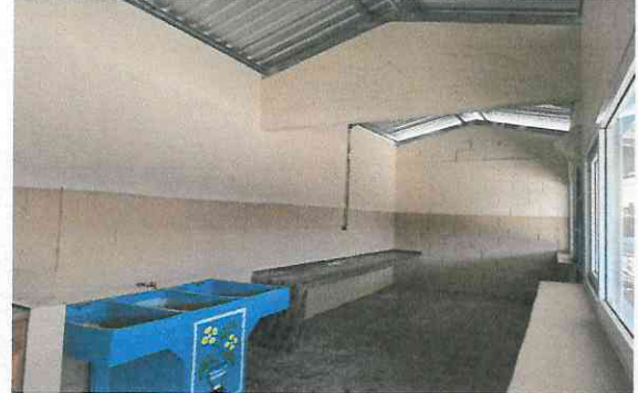
Foto 2: Levantado de paredes en área de la cocina.
