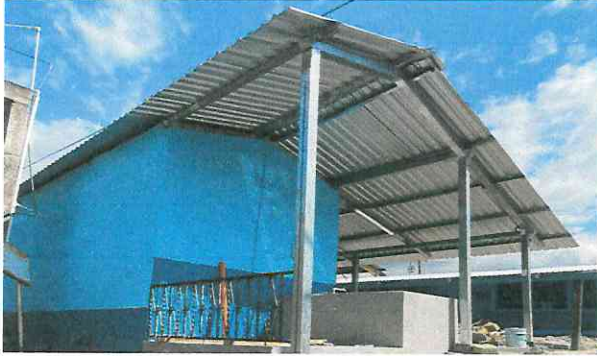
Foto1: Demolición e instalación de cubierta de techo de cocina y bases y techo de galera de área de pila y servidor de alimentos.
