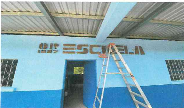
Foto 5: Sustitución de pintura interior y exterior
