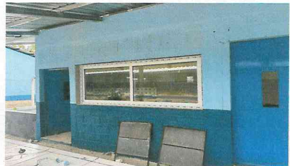
Foto 4: Sustitución de ventanales por ventanas de PVC.
